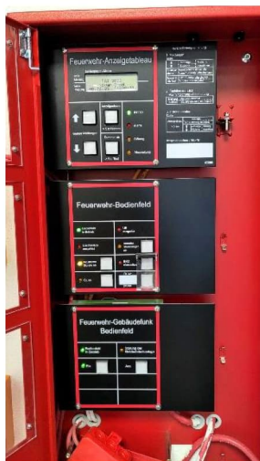
Couverture radio intérieure dédiée aux services de secours et de sécurité
