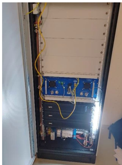
Couverture radio intérieure dédiée aux services de secours et de sécurité
